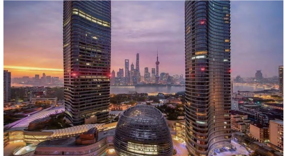
上海海泰北外滩项目
